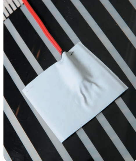
Рис. 25. Установленный и приклеенный датчик температуры пола. Вид снизу термолентки
