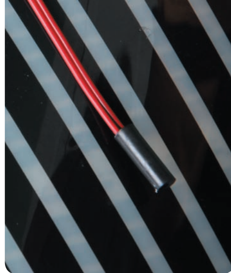
Рис. 22. Установка датчика температуры пола
