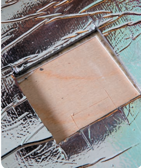
Рис. 23. Отверстие под датчик температуры пола в теплоотражающем материале
