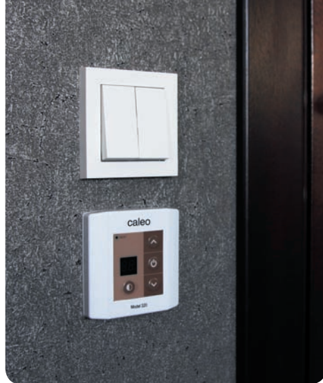
Рис. 27. Установленный терморегулятор.
