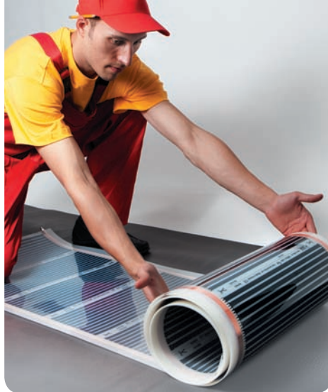
Рис. 6. Раскатывание рулона теплого пола на теплоотражающем материале
