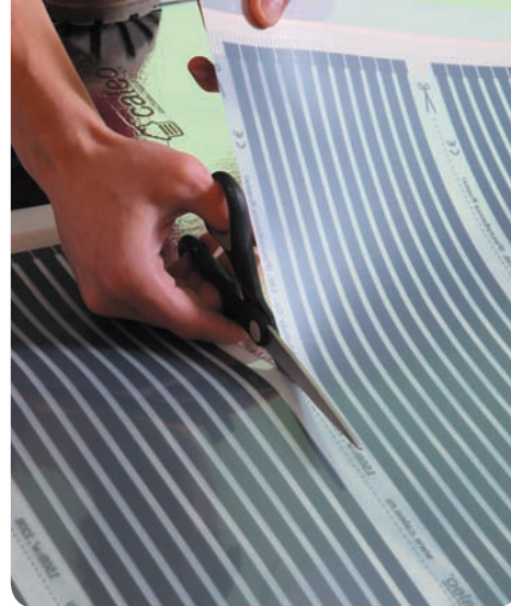
Рис. 7. Разрезание термопленки CALEO по линиям отреза
