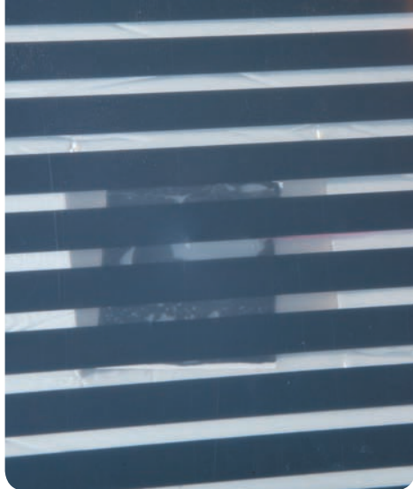
Рис. 26. Установленный и приклеенный датчик температуры пола. Вид сверху термопленки
